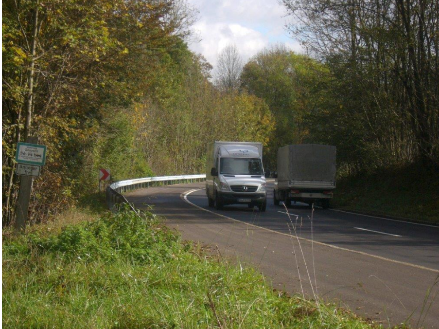
Bild 6: Verbreiterung und Sanierung des Rad- / Gehweges an der L 1152 zwischen Ebersbach und Weiler (Maßnahme 7.6)
