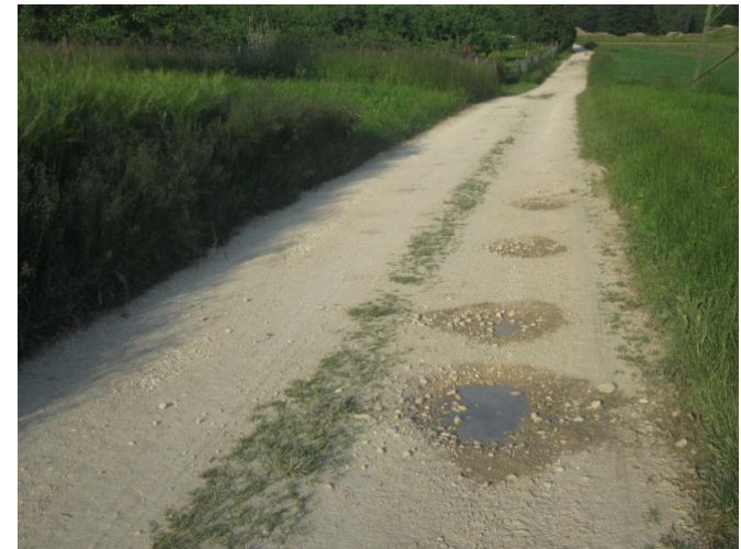
Abbildung 6.18: Aktuelle Situation am Wirtschaftsweg zwischen Roßwälden und Hochdorf
