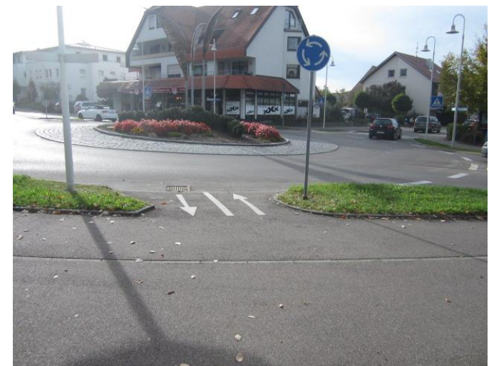
Abbildung 7.9: Radwegzufahrt an einem Kreisverkehr in Eislingen
