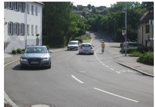
Abbildung 6.8: Beispiel eines einseitigen Schutz- streifens bergauf aus Uhingen
