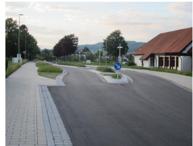
Abbildung 6.26: Querungshilfe in der Ortseinfahrt von Fried- richshafen-Kluffern
