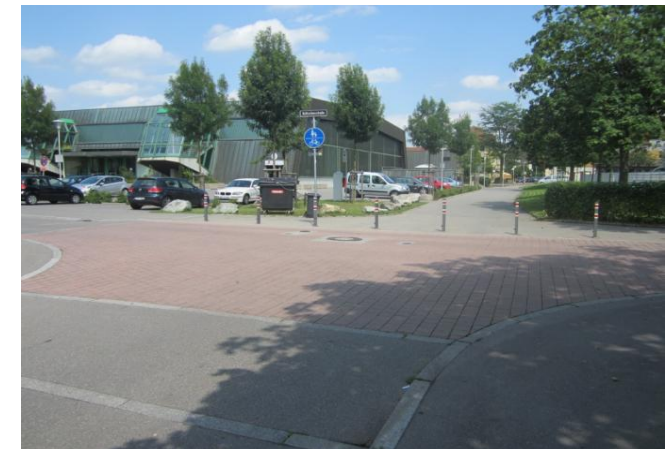
Abbildung 6.12: Aufpflasterung eines Knotens im Schulquartier in Friedrichshafen
