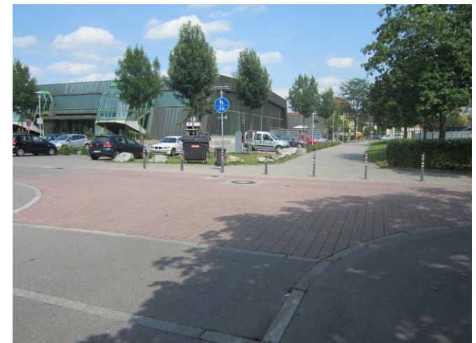
Abbildung 6.24: Aufpflasterung eines Knotens im Schulquartier in Friedrichshafen
