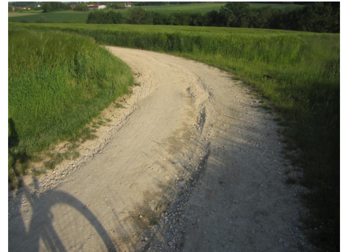
Abbildung 6.17: Aktuelle Situation am Wirtschaftsweg zwischen Roßwälden und Hochdorf
