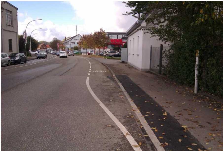
Bild 4: Neue Schutzstreifen in der Hauptstraße (Maßnahme 7.1)
