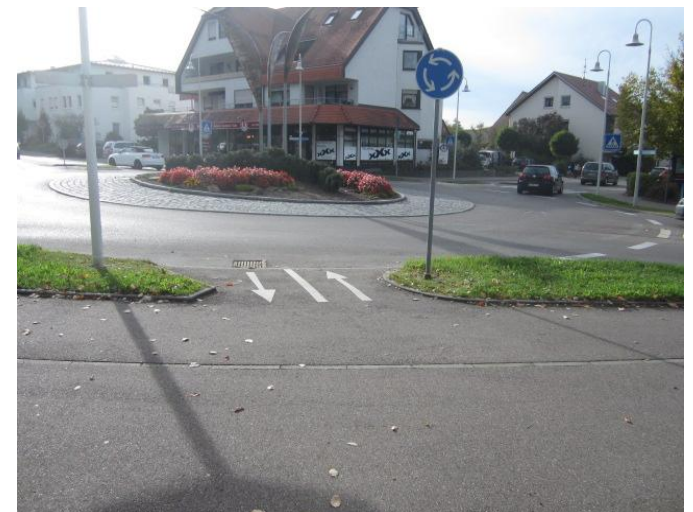
Abbildung 7.15: Radwegzufahrt an einem Kreisverkehr in Eislingen
