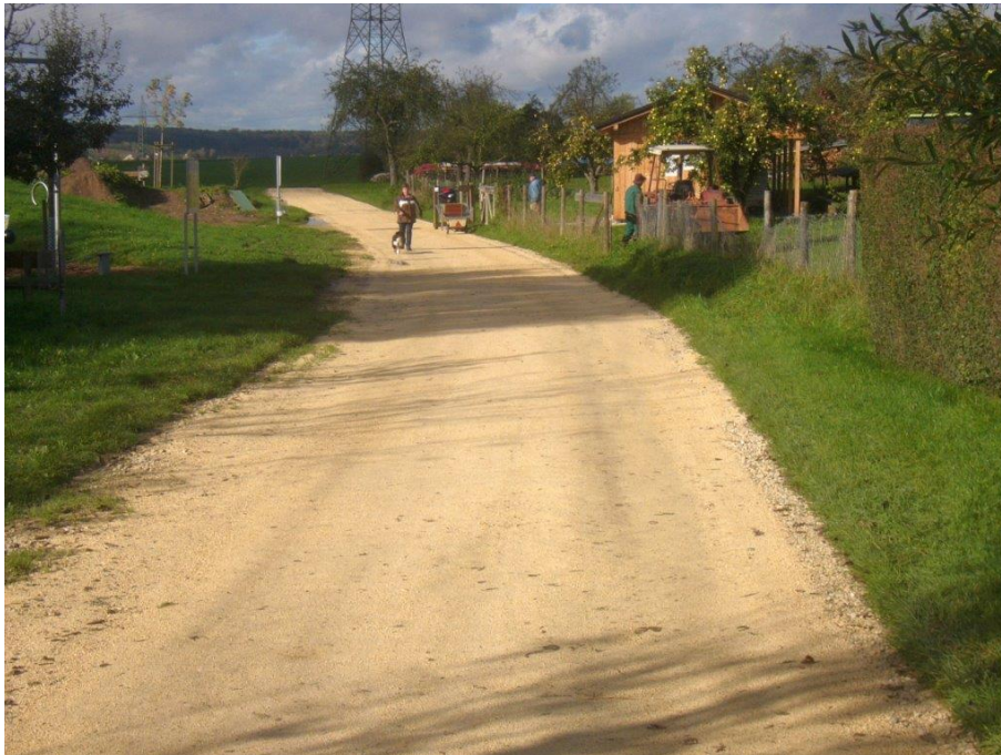
Bild 7: Sanierung des Wirtschaftsweges zwischen Roßwälden und Hochdorf (Maßnahme 7.8)
