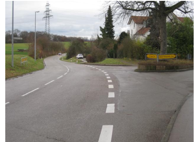
Abbildung 8.4: K 1414 am östlichen Ortseingang von Bünzwangen
