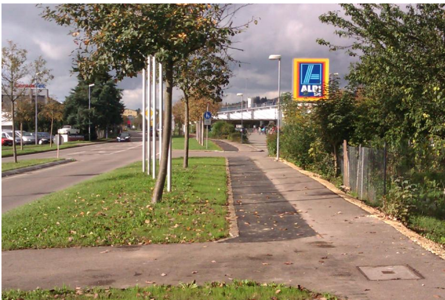
Bild 5: Verbreiterung eines Gehweges an der Hauptstraße zu einem Rad-/Gehweg (Maßnahme 7.2)
